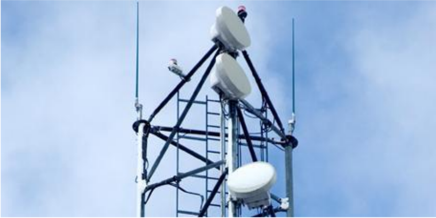
Рисунок 5.1 – Вигляд виносної підсистеми Ericsson Mini Link
