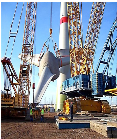
Рис. 4.65. Підняття вітроколеса на вежу
