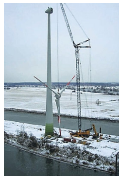
Рис. 4.52. Монтаж вітрового колеса
