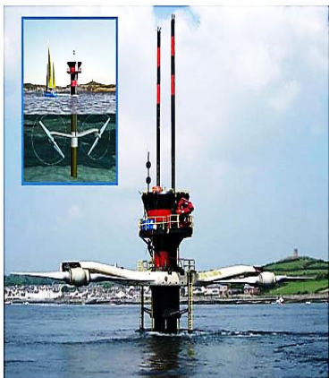
Рис. 5.103. Найпотужніша в світі приливна турбіна (1,2 МВт), Турбіна SeaGen, Стренгфорд Лаф, Ірландія, http://www.journal.esco.co.uk/2011_8/art180.htm
