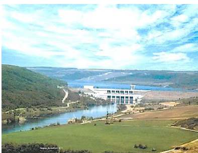
Рис. 5.15. Дністровська ГЕС. Вигляд з нижнього б'єфа
