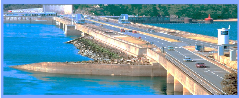
Рис. 5.96. Дамба першої в світі припливної електростанції в гирлі річки Ранс. Франція
