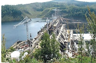
Рис. 5.17. На будівництві Бурейської ГЕС (Амурська обл.) Росія. 2004
