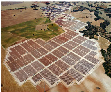
Рис. 2.38. Найпотужніша (2009) в світі фотоелектрична станція (60 МВт), Olmedilla Photovoltaic Park, Ольмеділья-де-Аларкон, Іспанія http://www.journal.esco.co.ua/2011_8/art180.htm
