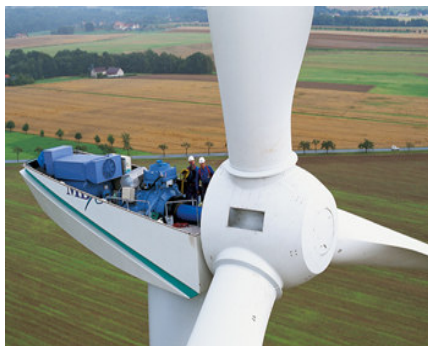
Рис. 4.50. Монтаж вітроенергетичної установки – встановлення внутрішнього обладнання гондולי
