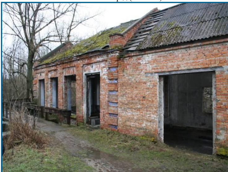
Рис.9.11. Будівля малої гідроелектростанції в с. Кам'яний Брід
